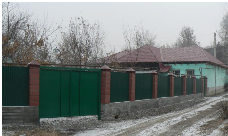
Fot. 5 Nowe ogrodzenie na tyłach naszej kaplicy w Osh
