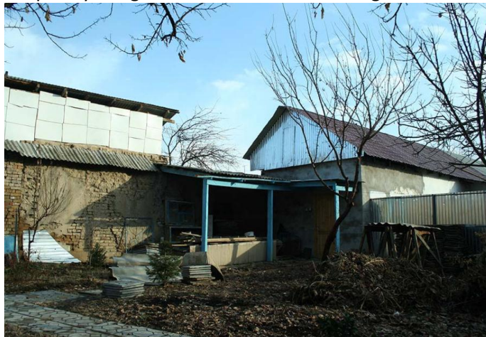
Fot. 3 Wejście do remontowanego nowego baruku od strony parafialnego ogrodu.
